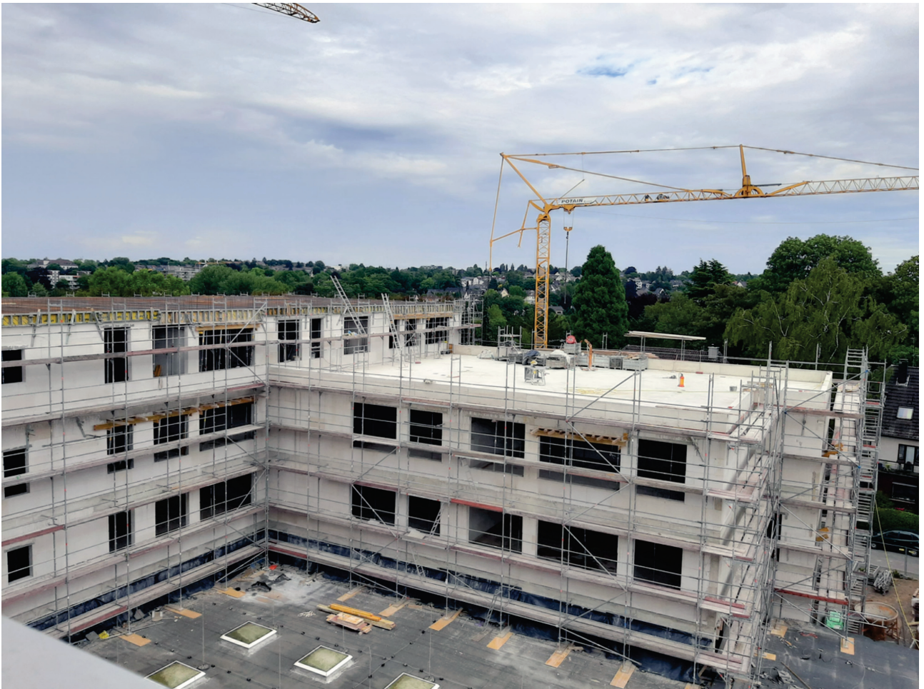
Anlage: Foto des Großbaustelle Otto-Pankok-Gymnasiums
